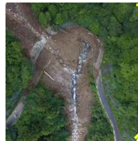
崩落のドローン画像
