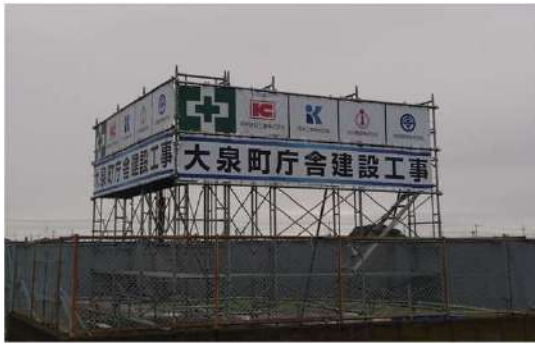
新庁舎建設工事が始まりました！
